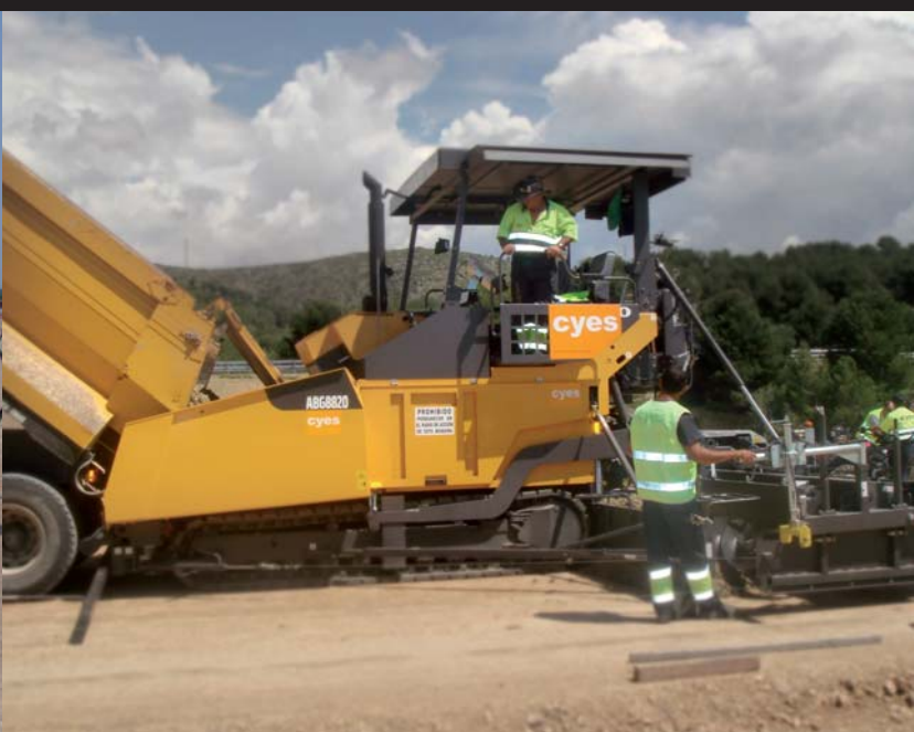
Extendido de suelo cemento
