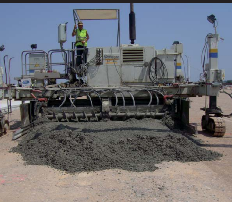
Extendido de hormigón
