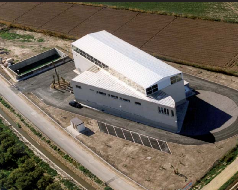
Estación Depuradora de Aguas Residuales de Almoradi, Alicante
