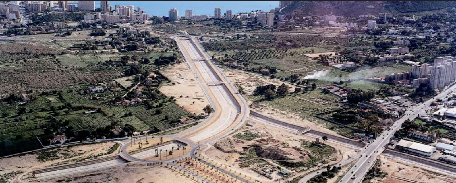
Encauzamiento de los Barrancos Juncaret y Orgegia, Alicante
