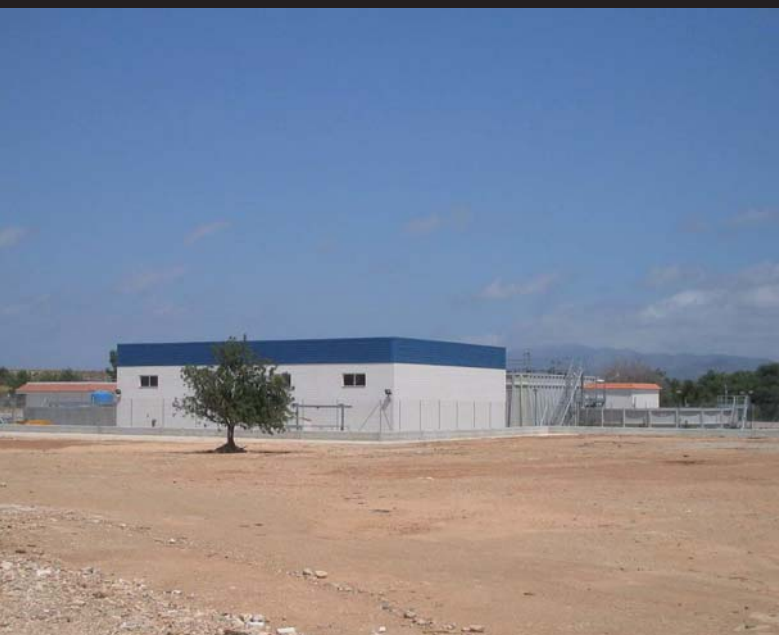
EDAR Urbanización "Nova Panorámica" en San Jorge, Castellón
