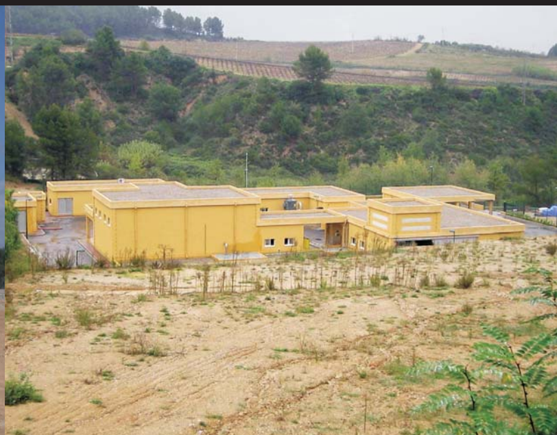
EDAR Urbanización Campo Golf "Masía Bach" en San Esteve Sesrovires, Barcelona
