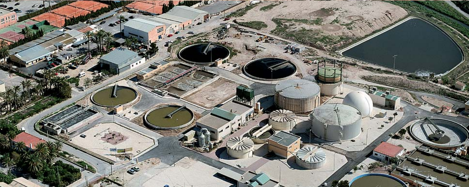
Ampliación de la Estación Depuradora de Aguas Residuales de Algorós en Elche, Alicante
