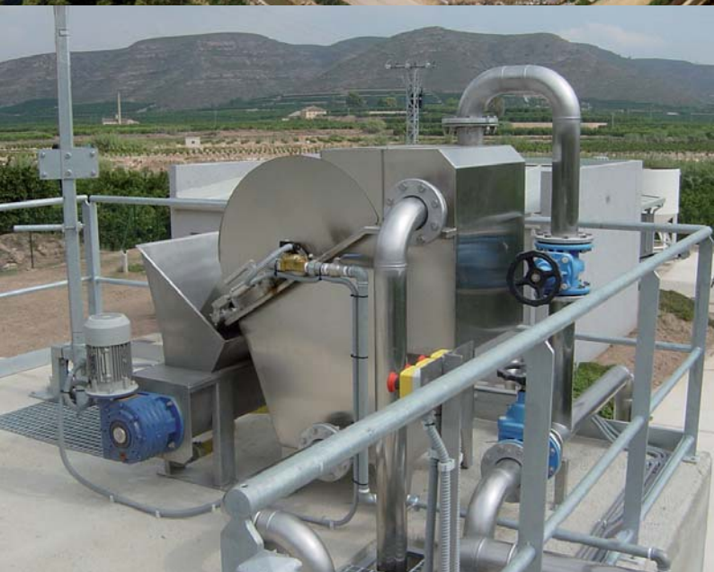
Estación Depuradora de Aguas Residuales de Sumarcacer, Valencia
