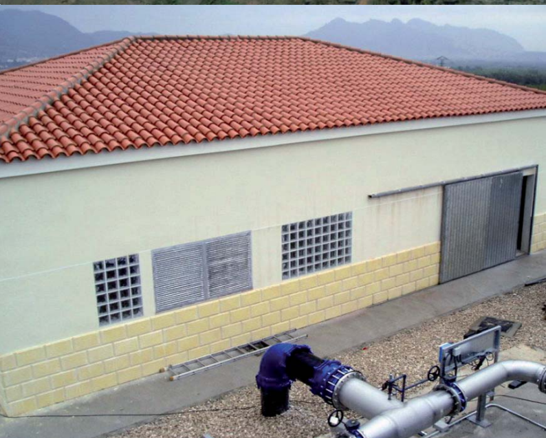
Estación de Tratamiento de Agua Potable de Calpe, Alicante
