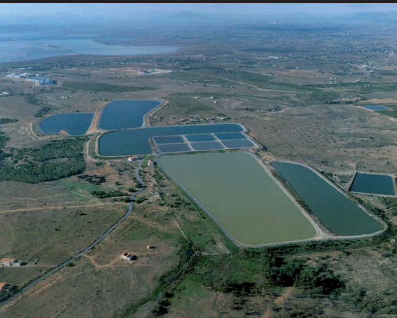
Red de Riego de la Estación Depuradora de Santa Pola, Alicante
